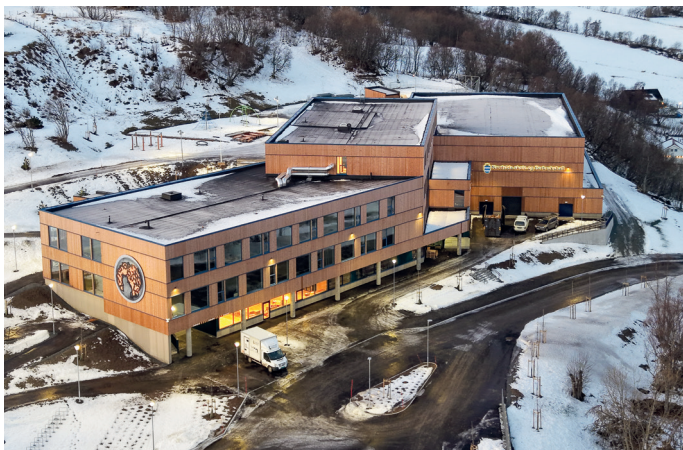
Skolebygget er lokalisert på Mustapartajordet, på en tomt med bratt terreng og fallretning mot nord. Foto: Øyvind Arvola/Harstad kommune
